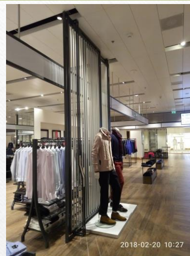
Київський ЦУМ. Рівень «-1» – збирання та монтаж декоративних перегородок з металу та триплексованого скла.
