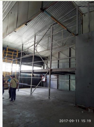
ТОВ «Європродакшн». Виконання проєкту з розділення складського приміщення на два поверхи з використанням металопрокату.
