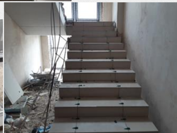
ЖК RiverStone, Дніпровська набережна. Облицювання стін, підлоги та сходових маршів керамічною плиткою. Монтаж стель Армстронг. Конструкції із ГКЛ систем.
