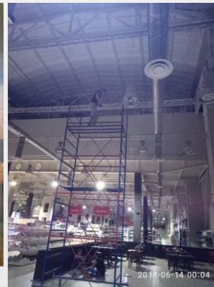
ТРЦ "Космополіт". Виготовлення та монтаж підвісної кубоподібної стелі загальною площею 320м 2 у приміщенні кафе та у тамбурах ТЦ «МегаМаркет»
