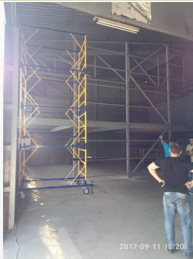
ТОВ «Європродакшн». Виконання проєкту з розділення складського приміщення на два поверхи з використанням металопрокату.
